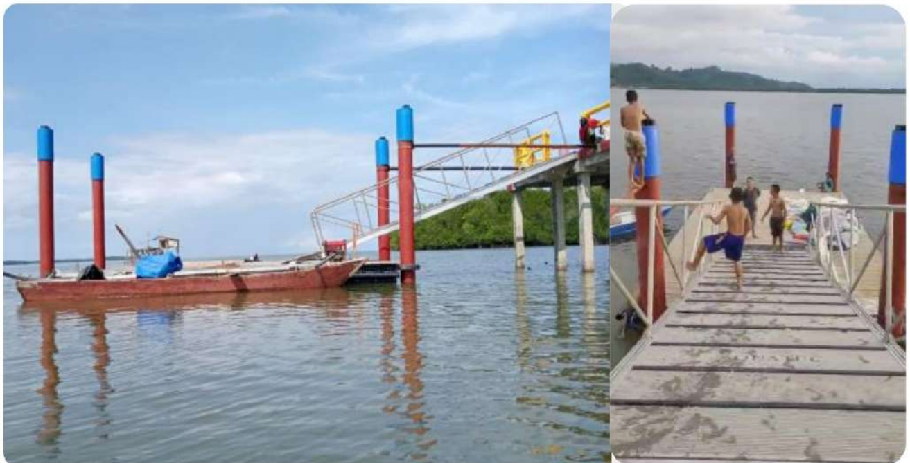
Gambar 6. Dermaga Apung di Pulau Kambunong, Kab. Mamuju Tengah (Tahun 2023)
