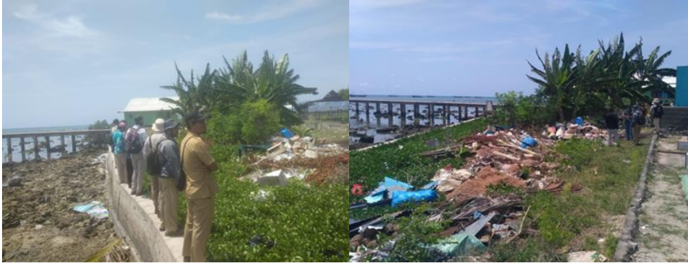
Gambar 58. Survei Pembangunan TPS/PDU di Pulau Buku Limau, Kab. Belitung Timur
