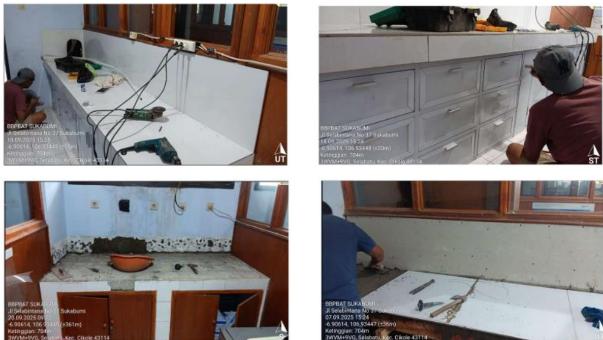
Gambar 8. renovasi bangunan telah dilaksanakan di Laboratorium Kesehatan Ikan dan Laboratorium Nutrisi dan Residu
