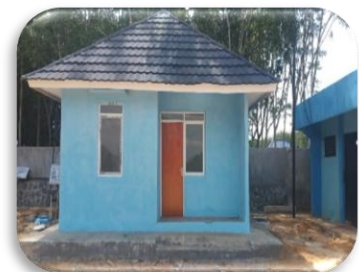
Pembangunan Rumah Jaga / Mess Operator PPBI Mesuji
