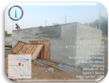
Pembangunan Bak Tandon
