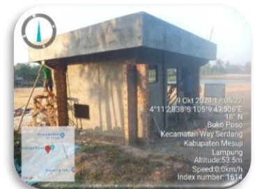
Pembangunan Ruang Genset
