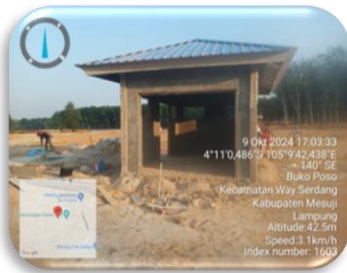
Pembangunan Gudang Pakan
