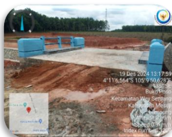
Pekerjaan Jembatan Lingkungan PBI Mesuji
