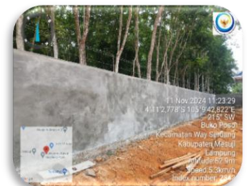
Pembuatan pagar pembatas area blok G PPBI Mesuji
