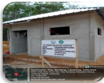
Pembangunan Ruang Blower
