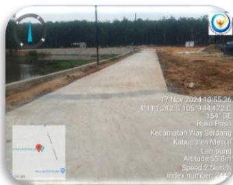
Pekerjaan Jalan Perkantoran
