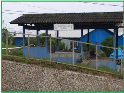
zat besi (Fe), Mangan (Mn), zat kapur (Ca). Selanjutnya menambahkan NaClO dan Ca(OCl)<sub>2</sub> untuk membunuh kuman dan menjernihkan air dan Active Carbon untuk menyaring dan menjernihkan ulang. Selanjutnya ditampung dalam penampungan (reservoar) berkapasitas sebesar 700 m<sup>3</sup> untuk siap didistribusikan
