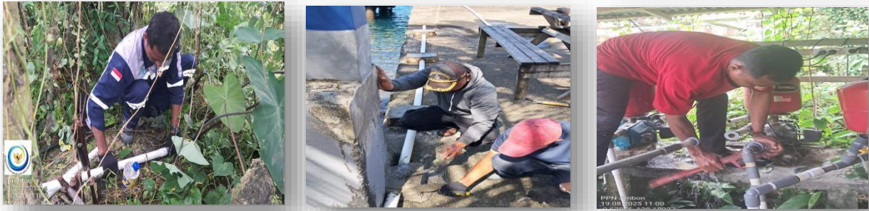
Gambar 27. Perbaikan Pipa Instalasi Air
