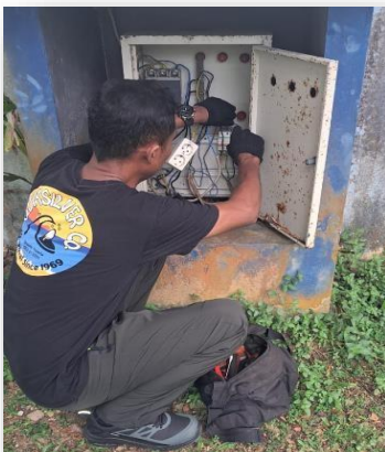
Gambar 26. Pemeliharaan panel induk listrik dan lampu jalan kawasan kantor
