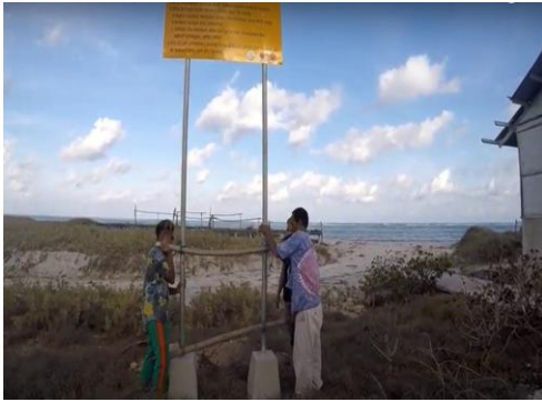
Gambar 56. Pemasangan rambu papan pemberitahuan gelombang pasang di Desa Kaliuda
